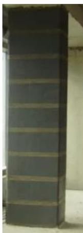
Программа предназначена для проектирования усиления железобетонной колонны путём устройства внешнего армирования композитным материалом согласно СП 164.1325800.2014 [1] и СП 63.13330.2018 [2]. Расчёт по прочности колонны, усиленной армированием в поперечном направлении, проводится на основе нелинейной деформационной модели с учётом повышения расчётного сопротивления бетона при объёмном напряжённом состоянии.
